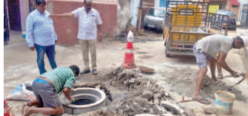
అభివృద్ధి పనులను పరిశీలిస్తున్న కార్పొరేటర్ సున్నం రాజ్ మోహన్
