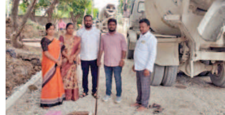
నార్సింగి మున్సిపల్ పరిధిలోని మంచిరేవులలో సీసీ రోడ్డు పనులు ప్రారంభిస్తున్న చైర్ పర్సన్ నాగపూర్తి
